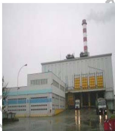
Figura 3.1: Impianto di incenerimento sito nell'area di Forlì, capace di trattare 18 t/h di rifiuti domestici
